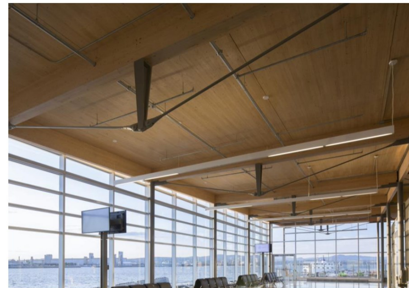
Poutre sous-tendue bois / acier
