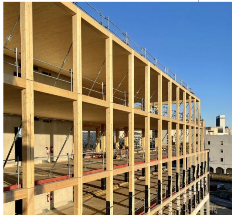
Structure mixte bois / béton
