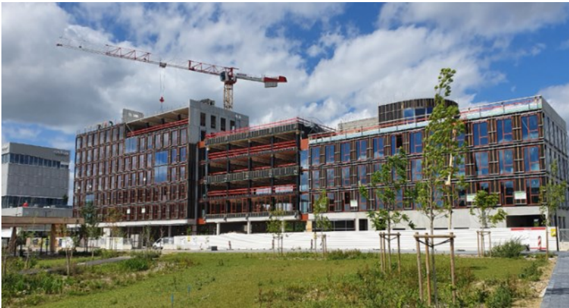
Architecte : HERAULT ARNOLD, PANTIN (93)
