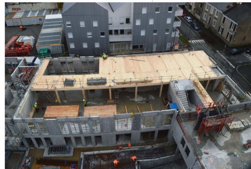
Structure mixte bois / béton
