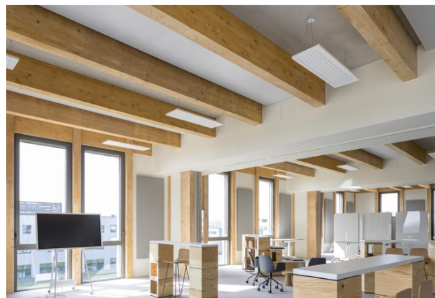
Plancher collaborant bois / béton
