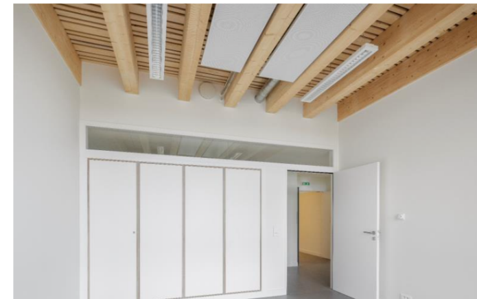
Plancher collaborant bois / béton
